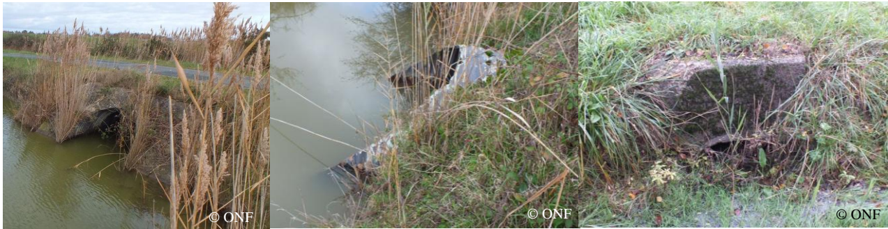
a) Buse avec tirant d'air 0,60 m – Les Fontaines ; b) Buse avec tirant d'air 0,65 m – Prise du Mitant ; c) Buse à sec – La Perjaillère
