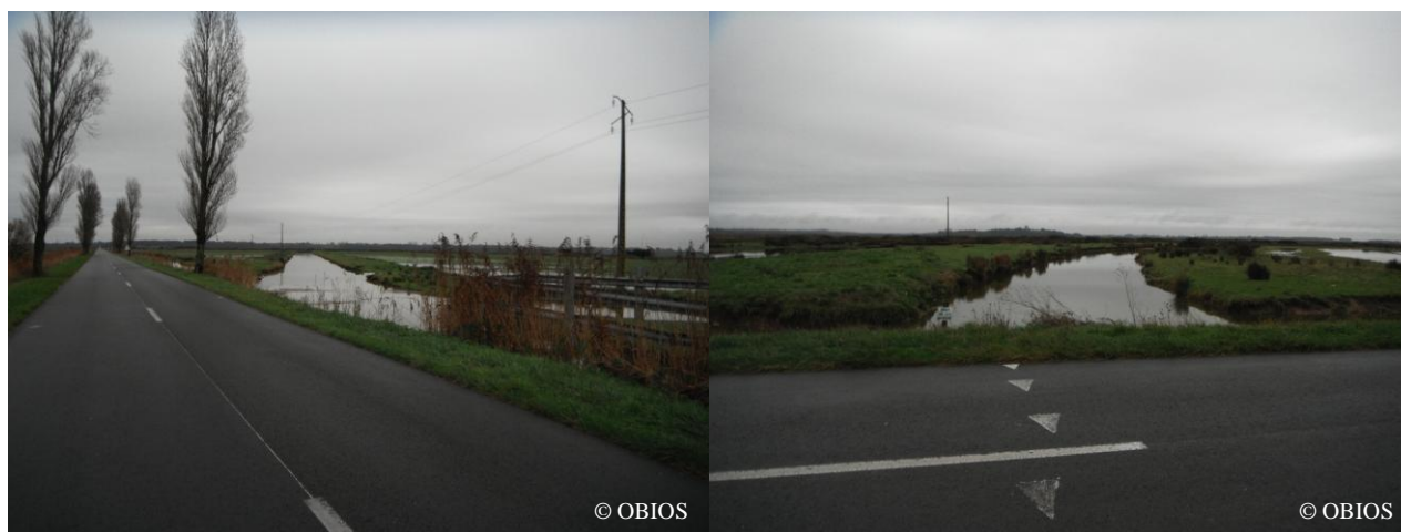
Photo 53 : Route départementale n°18
