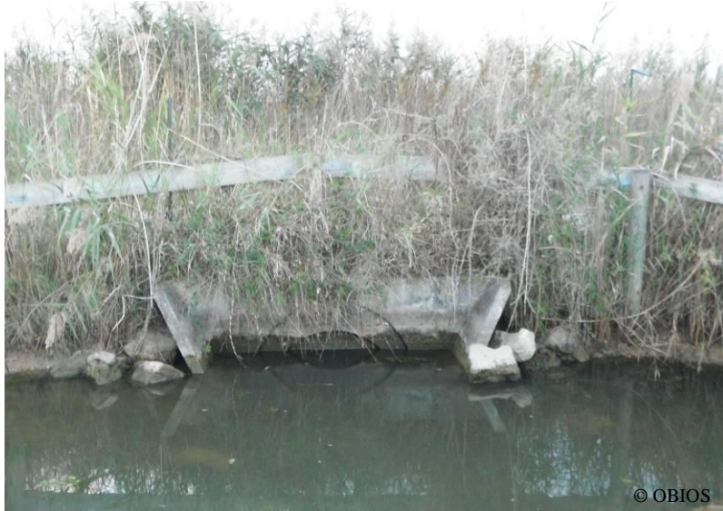
Photo 50 : Passage à Loutre aménagé sur la route départementale n°123
