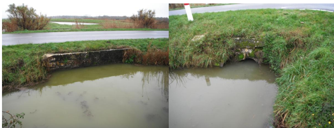
a) Ouvrage sous l'eau - Le Fiscarnaud
