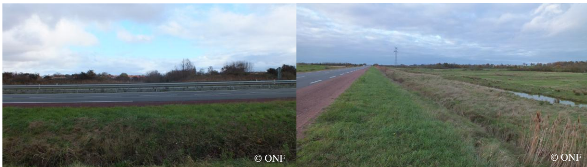
Photo 56 : Route départementale n° 733
