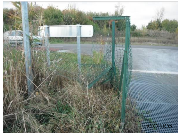
Photos 51a & b : Barrière canadienne et grillage de protection endommagé
