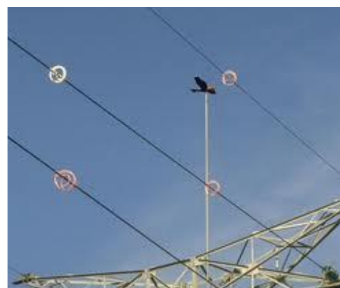
Balise de protection et dispositif d'effarouchement (RTE)
