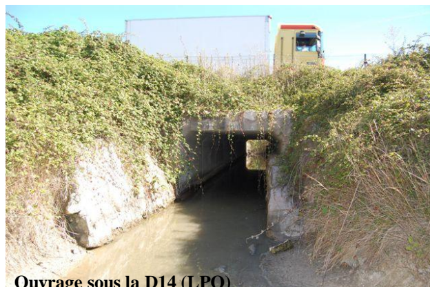
Ouvrage sous la D14 (LPO)
