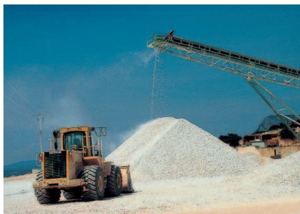
Déplacement des stocks de granulats
