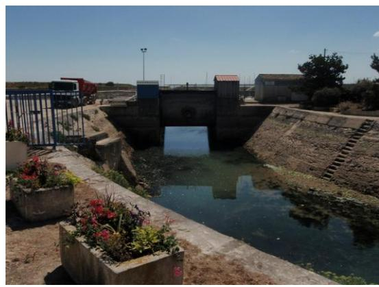
**Ecluse du Port du Douhet permettant la réalisation des chasses**
