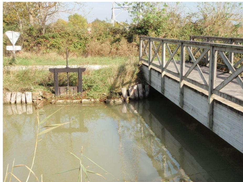
**Prise d'eau en amont des écluses de Bellevue (prise d'eau sur le canal de Broue)**
