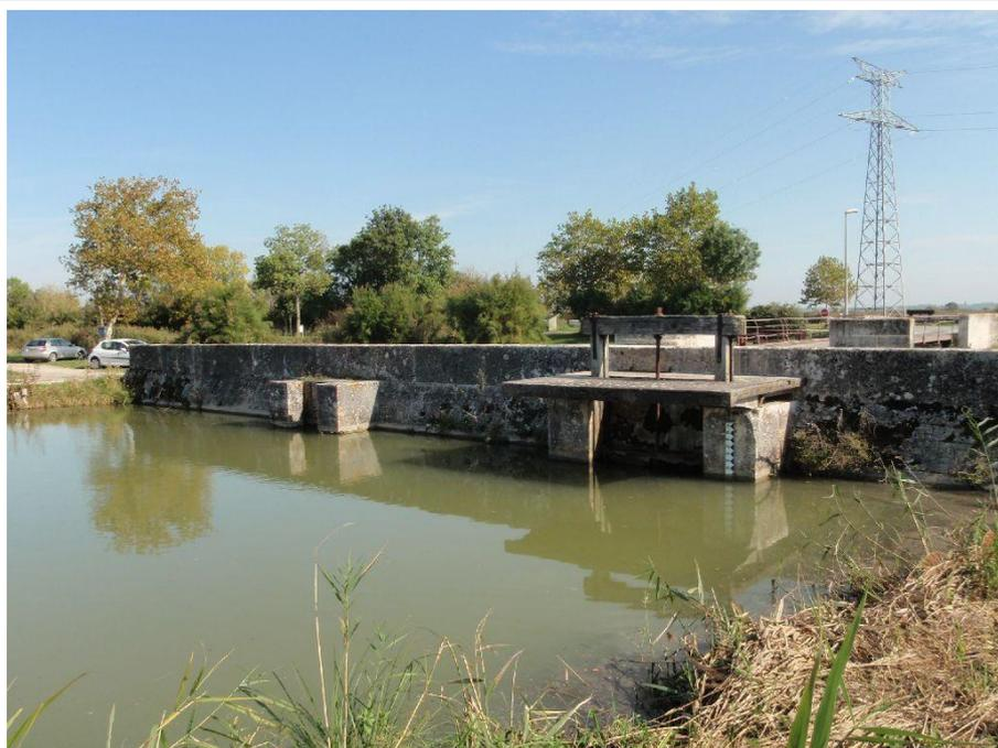
**Ecluses de Bellevue (et siphon permettant au canal de Broue de passer sous le canal Charente-Seudre – à gauche)**
