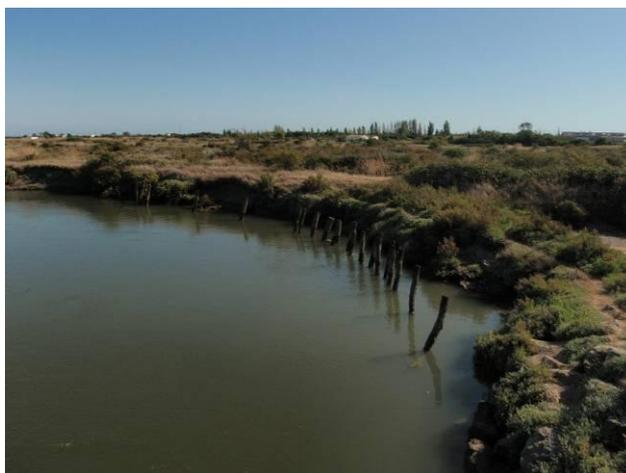
**Photo 5 : Dégradation des berges, marais d'Oulme**
