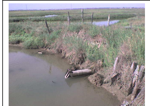
Clapet évitant à l'eau salé de remonter dans le réseau d'eau douce
