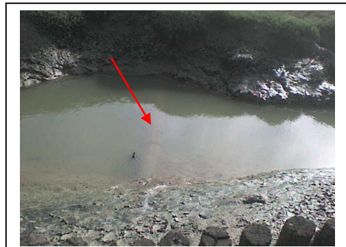
Tuyau souterrain permettant à l'eau douce de traverser un fossé en eau salée
