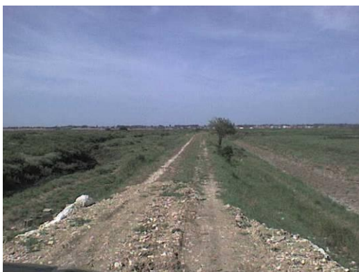
Photo 13 : Digue « Richelieu » : un point a été renforcé avec l'apport de matériaux
