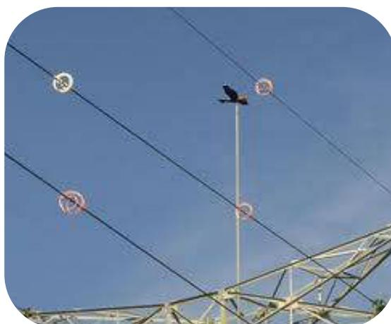
Balise de protection et dispositif d'effarouchement (RTE)
