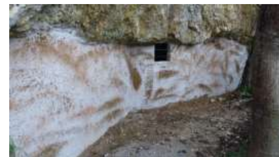
Exemple : édification d'un mur pour protéger une cavité à chauve-souris
