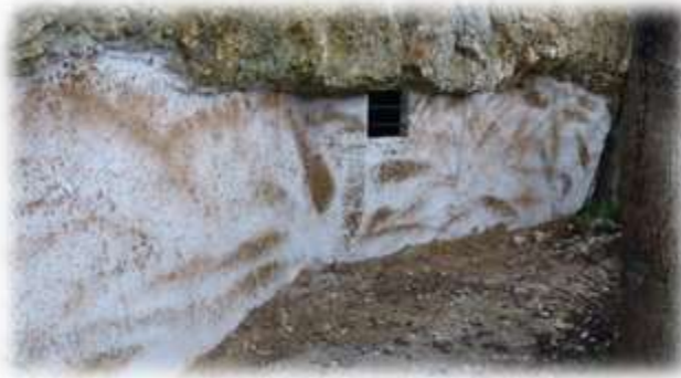
Exemple : édification d'un mur pour protéger une cavité à chauve-souris (St Sornin)
